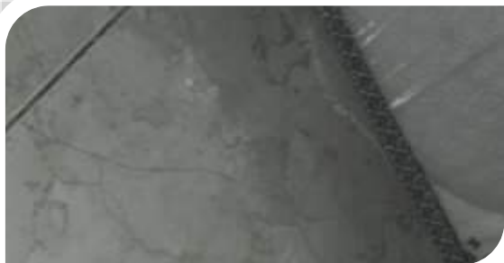
FOTO No. 7 Fisura Baldosa Ducha
